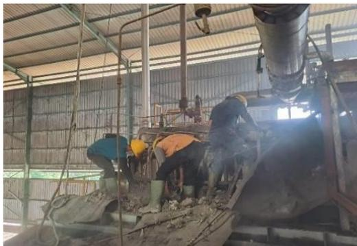
**Gambar 2.** Proses pembongkaran *superheater tube*
